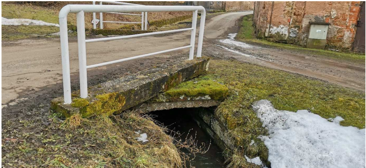
POHLED NA PROPUSTEK
