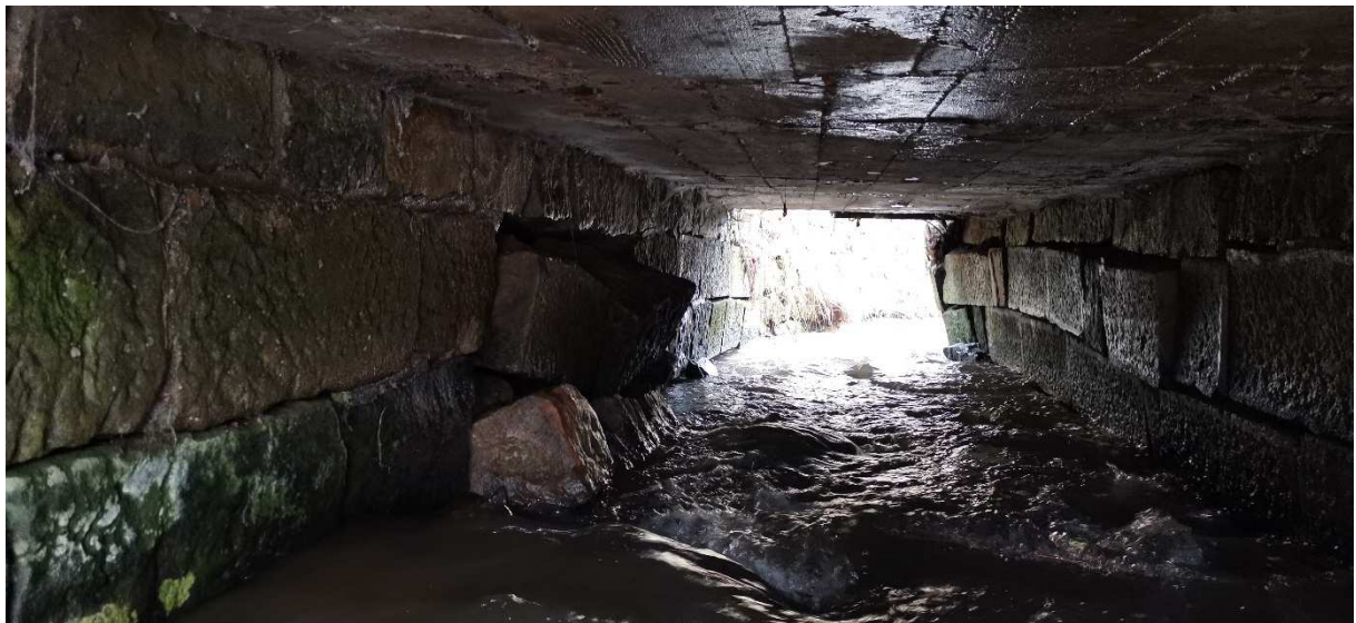
POHLED DO PROPUSTKU
